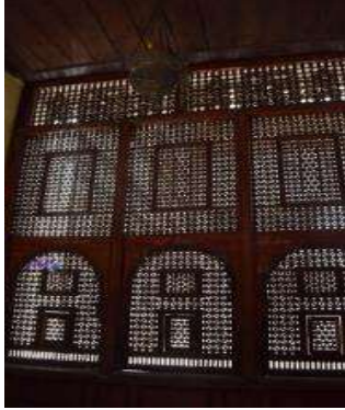
صورة رقم (٧) توضح استخدام الشبابيك المرتفعة في الطابق الأرضي والمشربيات المزخرفة بالخرط في الطابق الأول (Daniels
