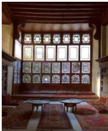
صورة رقم (١٤) لחד الغرف الصيفية (مساحة الفتحات المعمارية اكبر للسماح بتدفق الهواء) في البيت
