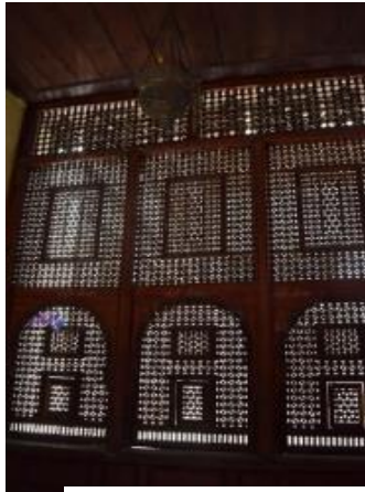
صورة رقم (٧) توضح استخدام الشبائيك المرتفعة في الطابق الأرضي والمشربيات المزخرفة بالخرط في الطابق الأول (Daniels n.d.)
