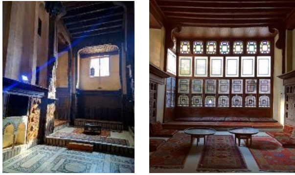
صورة توضح لاحد الغرف الصيفية (مساحة الفتحات المعمارية اكبر للسماح بتدفق الهواء) في البيت
